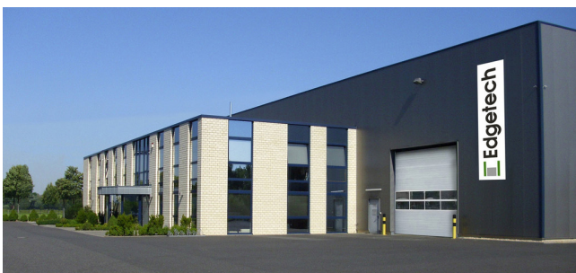
Firmengebäude der Edgetech Europe GmbH in Heinsberg.
